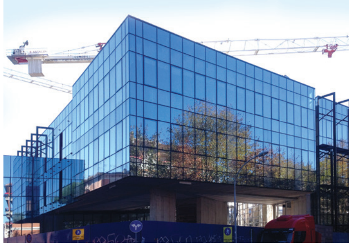
Nuova Sede Angelini a Roma - Lecablocco Tagliafuoco e Lecablocco Tramezza Lecalite - in corso di certificazione LEED.
