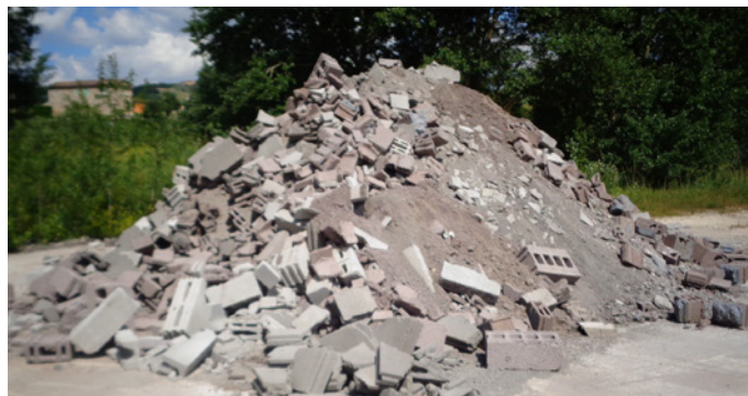
Macerie in seguito a demolizione selettiva per conseguente riutilizzo come inerte.
