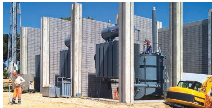
Bonifica acustica nella Stazione Terna di Roma.
