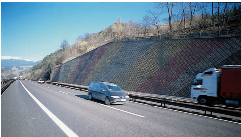
Rivestimento fonoassorbente a secco di un muro esistente in calcestruzzo con Lecablocco FonoLeca Quadro fissati con viti e tasselli.
