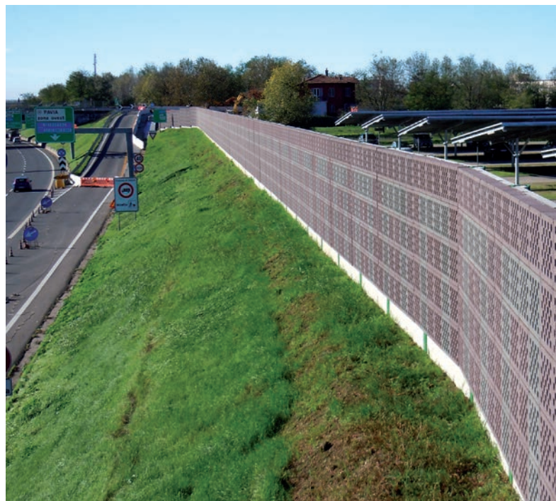
Barriera Fonoassorbente lungo la Tangenziale di Pavia.
