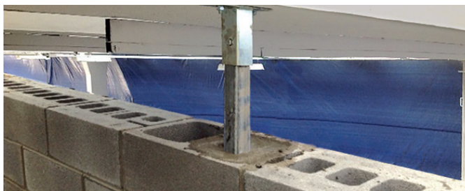
Vincolo laterale ad una trave prefabbricata. Un meccanismo telescopico consente di variare la lunghezza della parte orizzontale dell'elemento di collegamento adattandola alla distanza tra trave e muratura.
