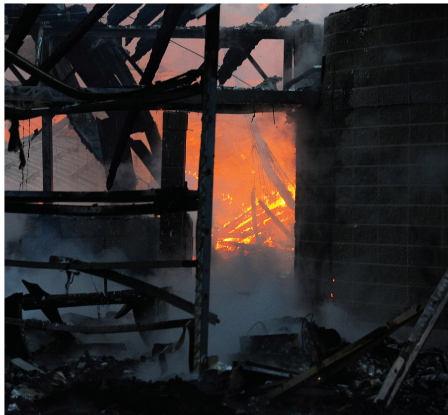
Le pareti in Lecablocco sono rimaste completamente intatte a differenza delle strutture metalliche interne e della copertura che è invece crollata.
