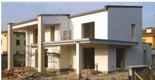
Edificio residenziale in Lecablocco Bioclima Zero18P con struttura a telaio in calcestruzzo di spessore 30 cm.
