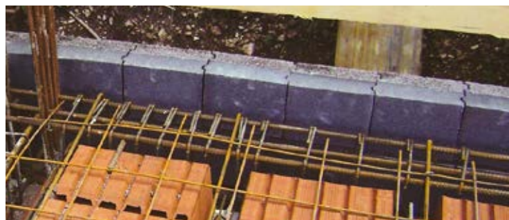
Parete di tamponamento in Lecablocco Bioclima Zero18P (pilastri in c.a. di spessore 30 cm) - Tavella Isolata in corrispondenza del cordolo di solaio.
