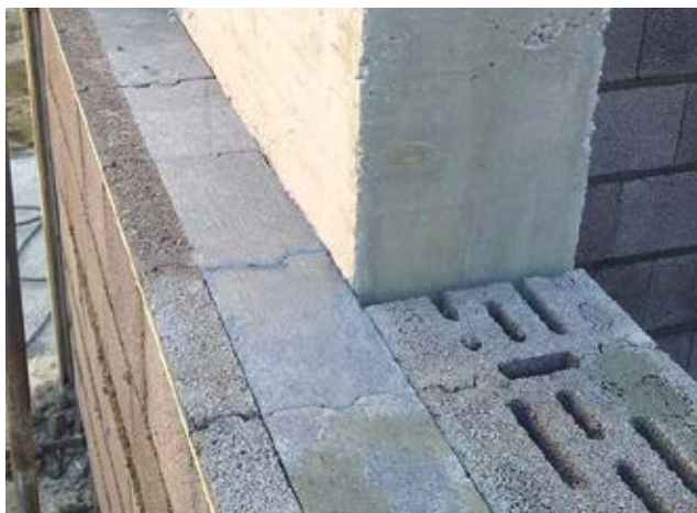
Parete di tamponamento con Lecablocco Bioclima Zero18P (setti in c.a. di spessore 25 cm).
