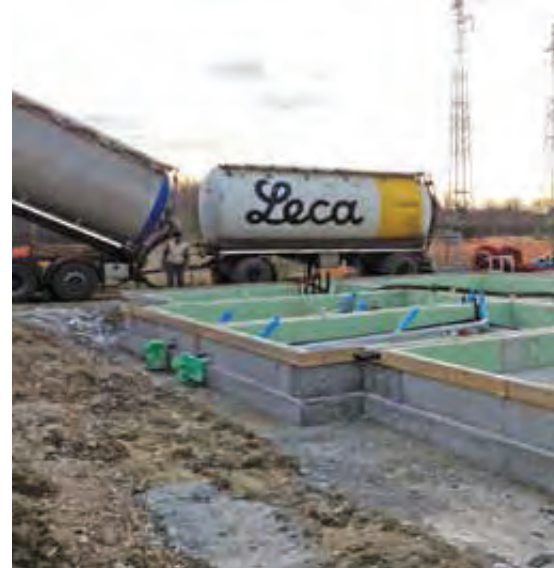
Applicazione Leca TermoPiù sulla fondazione tipo platea continua.
