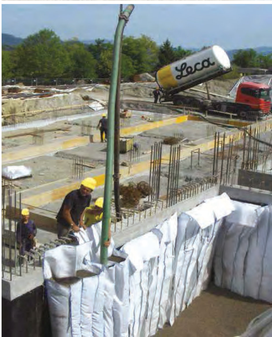
Applicazione TermoBag per l'isolamento termico delle pareti interrate →
