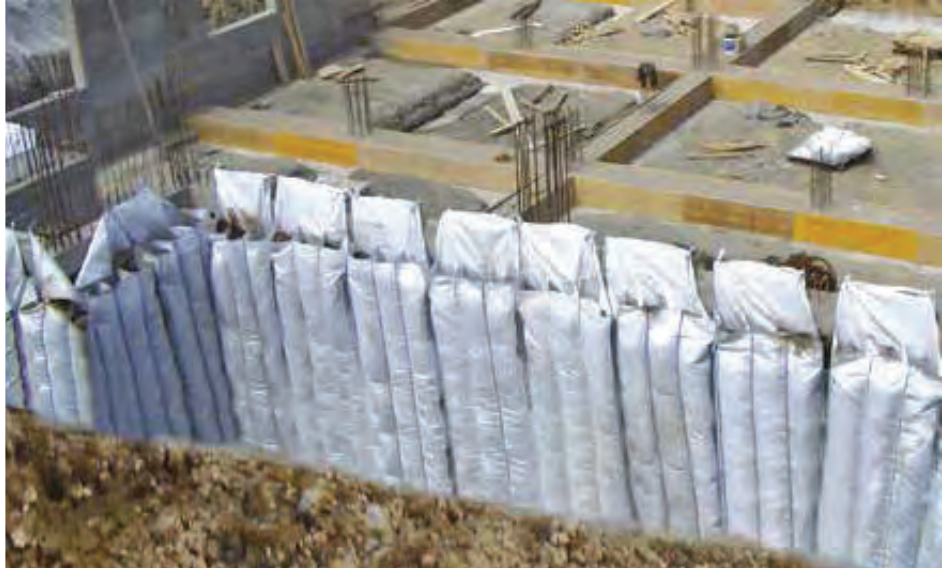
Applicazione TermoBag per l'isolamento termico delle pareti interrate →
