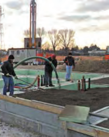
Applicazione Leca TermoPiù su fondazione tipo trave rovescia. ↑
