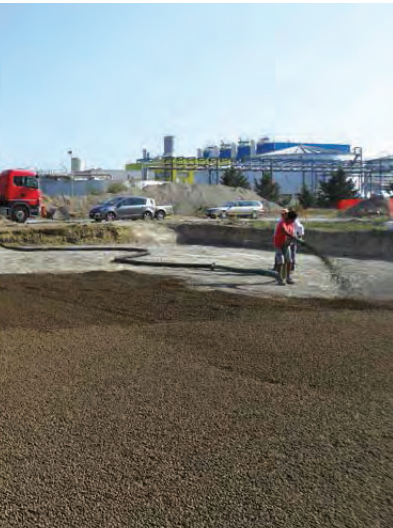
Applicazione TermoBag per l'isolamento termico delle pareti interrate →
