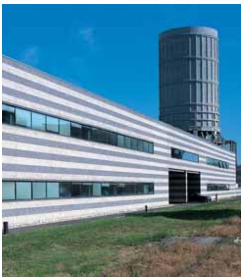
Muratura rinforzata in Lecablocco. Gli irrigidimenti verticali e orizzontali sono realizzati entro le cavità di pezzi speciali.
