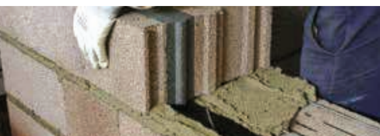
Inserimento del traliccio ogni due corsi e posa del corso successivo.
