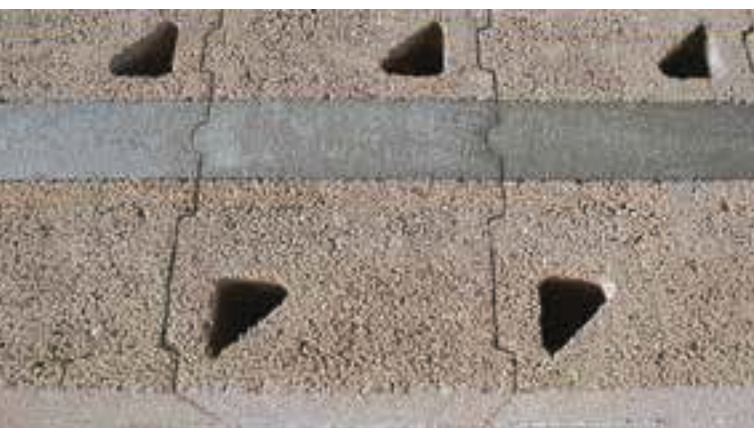
Posa unica del blocco ad incastro con i fori di presa.
