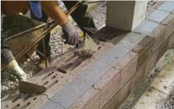
Correzione del ponte termico in corrispondenza del pilastro con tavella isolata.
