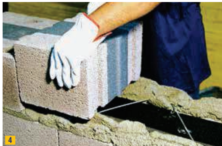
Posa del corso successivo di blocchi.
