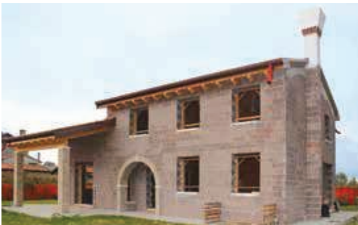
Parete non intonacata.
