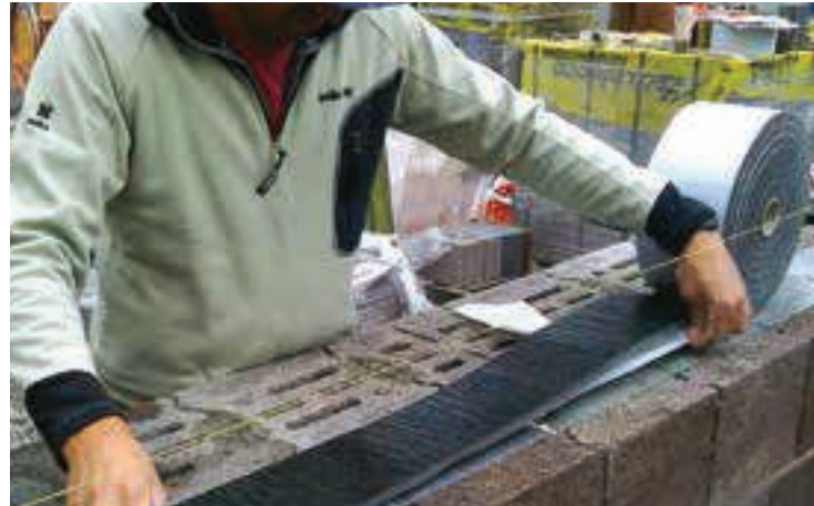
Posa della striscia isolante adesiva.
