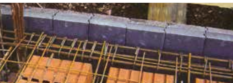
Posa della tavella isolata in corrispondenza del cordolo di solaio.
