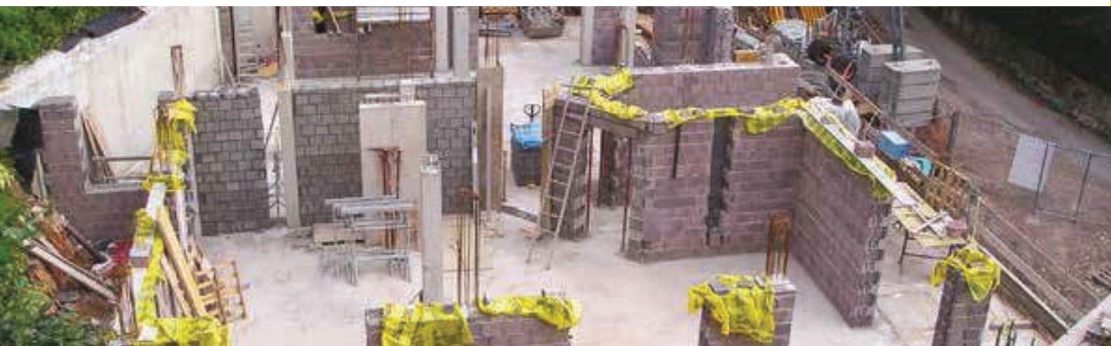
Edificio in classe A con Lecablocco Bioclima Zero 27p.
