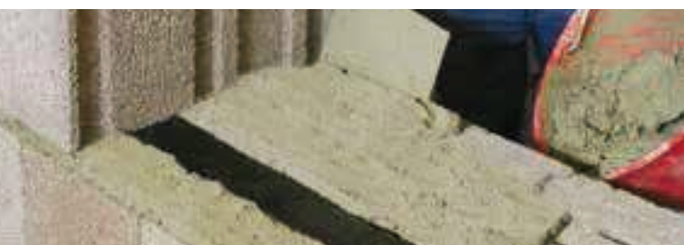
Posa della malta su due strisce.
