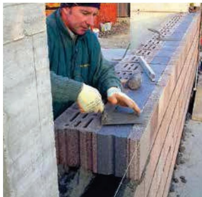
Particolare di posa del Lecablocco Bioclima Zero18p.
