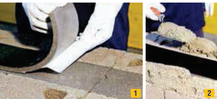
Posa della striscia isolante e stesura della malta.
