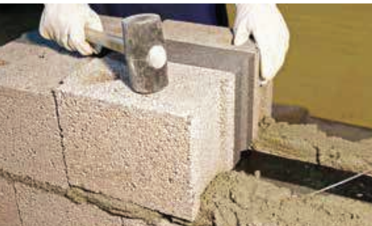
Posa del corso di blocchi.
