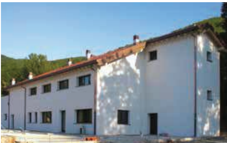
Albergo in costruzione con Lecablocco Bioclima Zero 23t.
