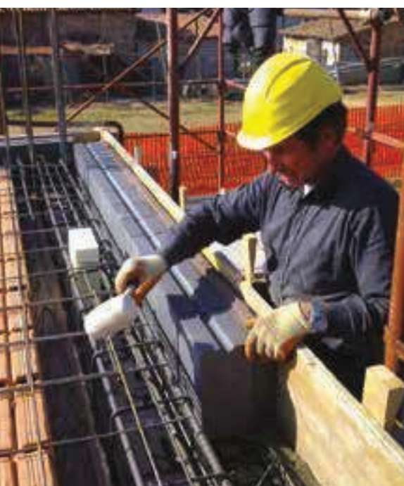
Posa della tavola isolata in corrispondenza del cordolo di solaio.
