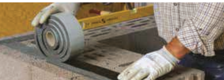
Posa della striscia isolante adesiva.
