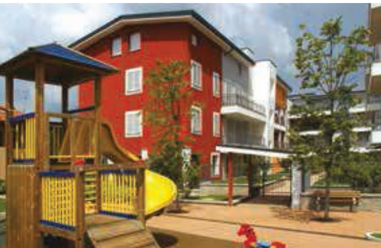
Edificio in classe A con Lecablocco Bioclima Zero 27p.
