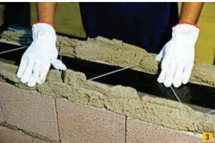
Posizionamento del traliccio metallico Murfor.
