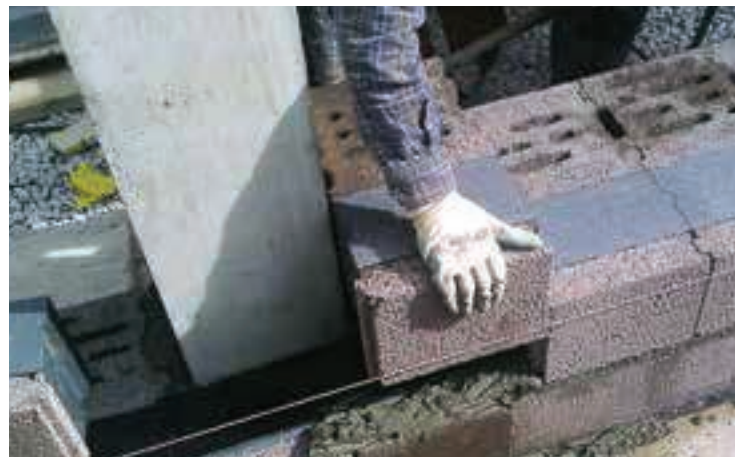
Posa del Lecablocco Bioclima Zero 18p in corrispondenza del pilastro.
