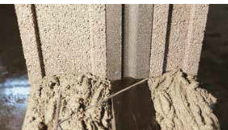
Posa del blocco con striscia isolante e traliccio metallico Murfor.
